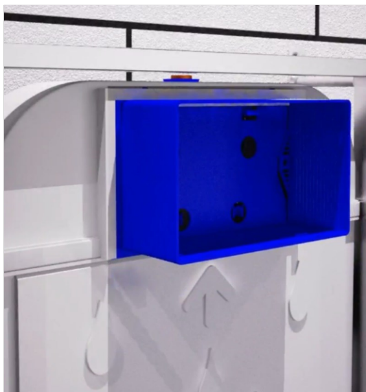
Установите форму для соединения панелей.
